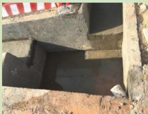
基坑周边临时沉砂池 1
