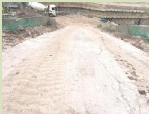
部分出土坡道路面硬化
