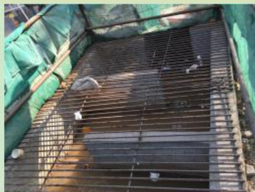
施工区内现有临时沉砂池2
