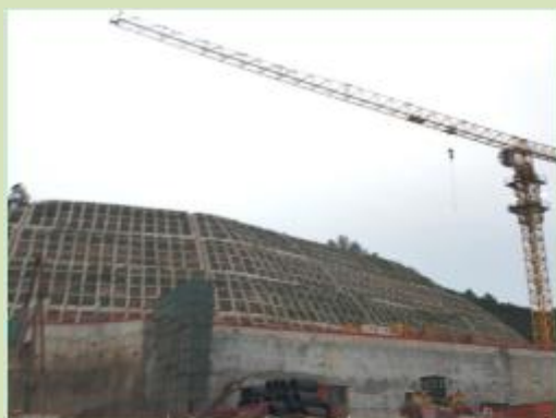
区内山体边坡区防护现状 1
