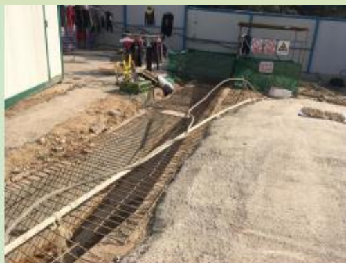
施工区周边临时排水沟现状 1
