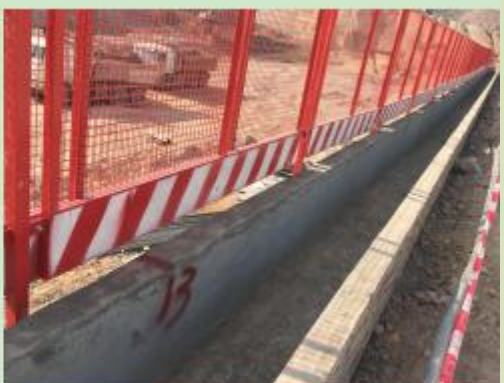
基坑周边现有临时排水沟 5
