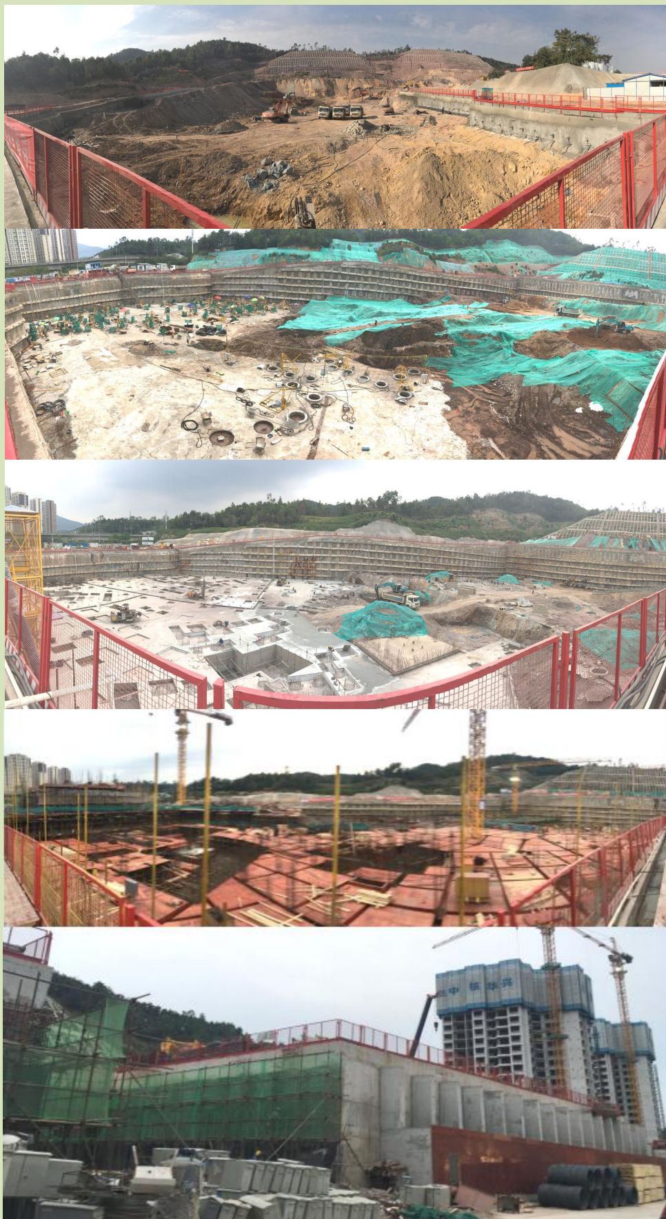
项目区各阶段各角度整体施工现状
