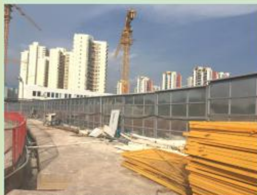
部分基坑边围墙内侧周边现状
