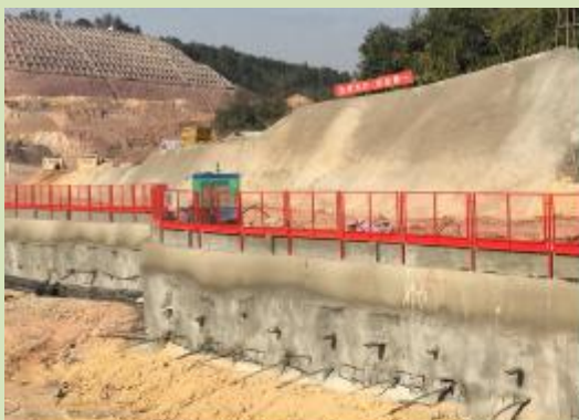
现有基坑边坡周边防护现状
