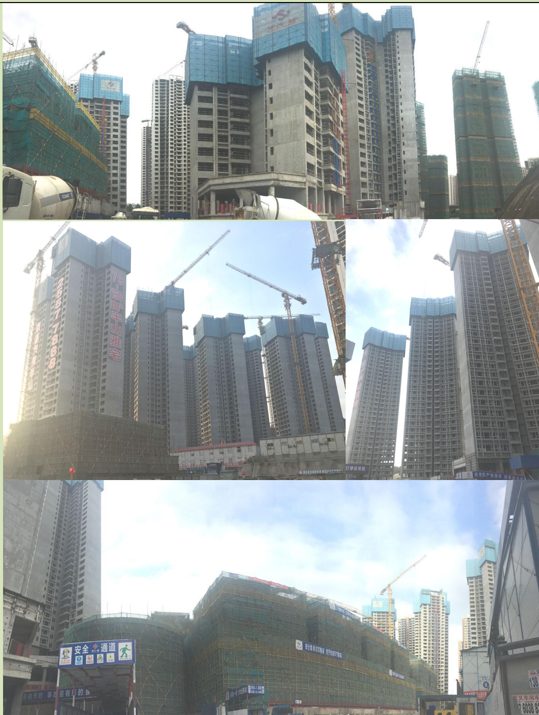
项目区主体建筑各角度整体施工现状
