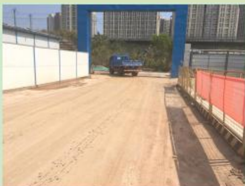
施工区出入口道路周边硬化
