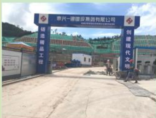
施工区主要道路硬化现状1
