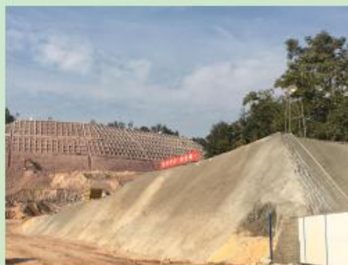
施工区内现有边坡防护现状
