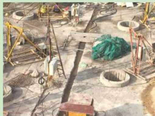
坑底部分临时排水沉沙设施 1
