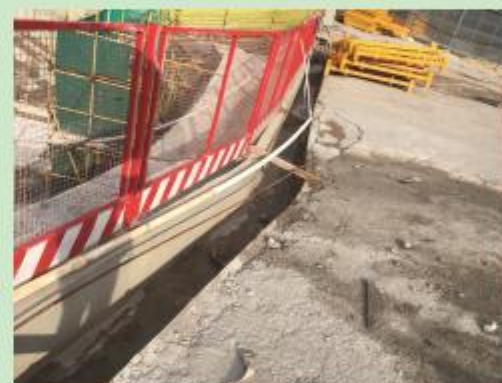
基坑周边临时排水沟 4
