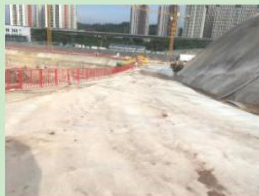
施工区主要道路硬化现状2
