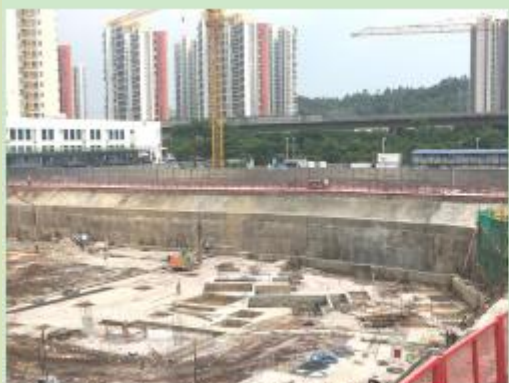
坑底硬化及边坡防护现状 1
