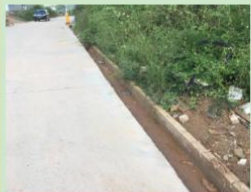
施工进场道路及路边排水沟
