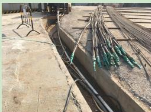
施工区周边临时排水沟现状 2
