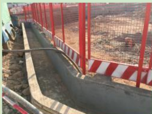
基坑周边现有临时排水沟 4
