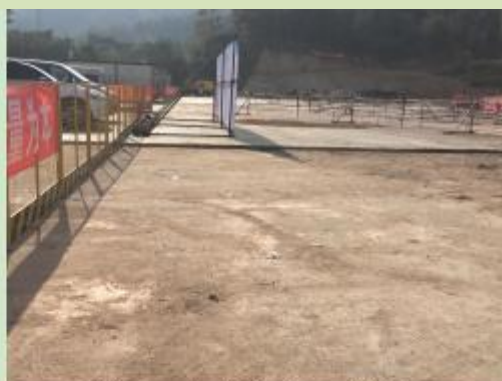
施工区内停车场及堆料区
