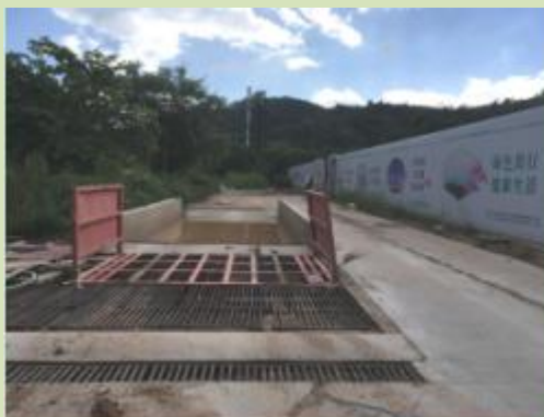
出入口洗车池周边现状
