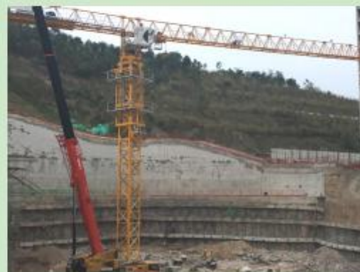
山体一侧基坑边坡防护现状 2
