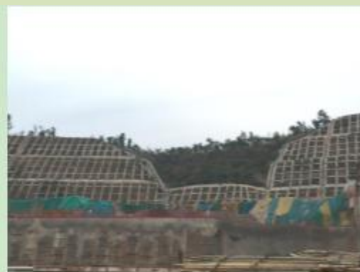
区内山体边坡区防护现状 2
