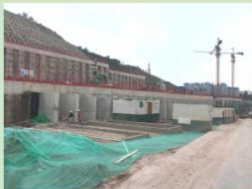
山体边坡区挡土墙施工现状
