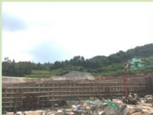
区内山体边坡区防护现状 3
