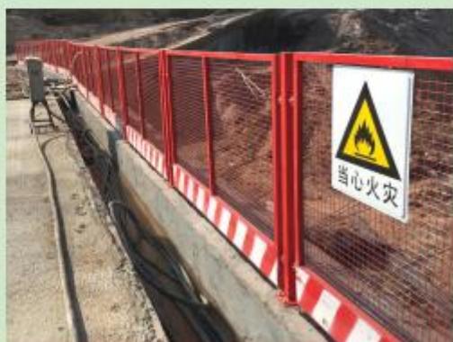
基坑周边现有临时排水沟 1
