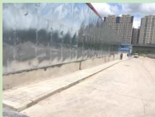
总包办公区靠施工道路一侧围墙
