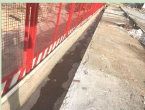
基坑周边临时排水沟 3
