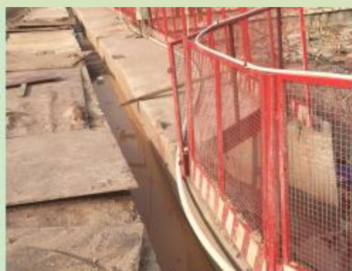
基坑周边临时排水沟 1
