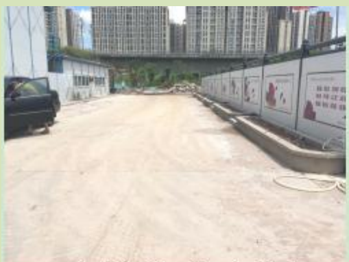
部分新增围墙及绿化池
