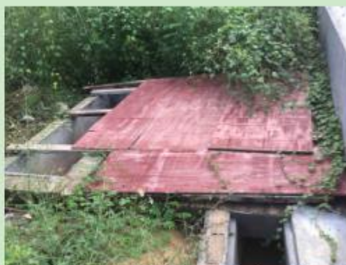
排水出口处多级沉砂池现状
