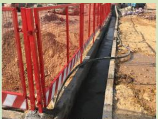
基坑周边现有临时排水沟 3
