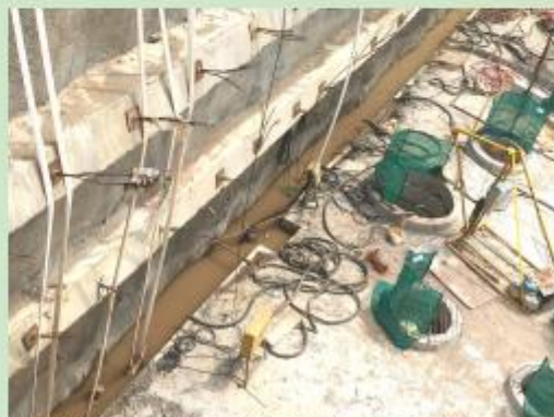
坑底部分临时排水沉沙设施 2
