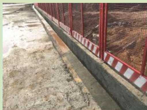
基坑周边现有临时排水沟 2
