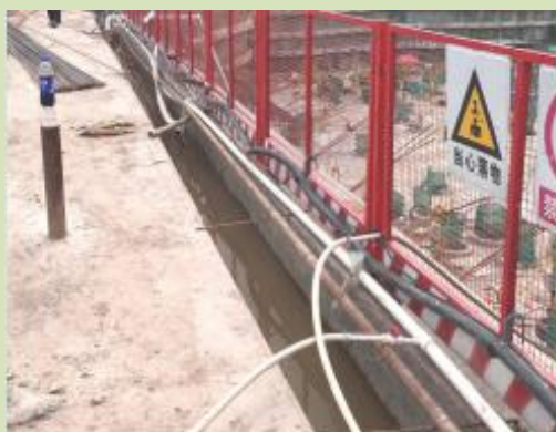
基坑周边临时排水沟 4
