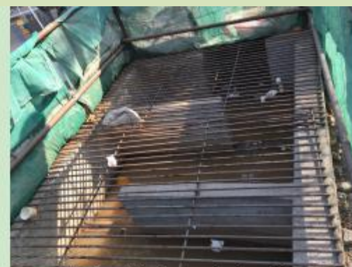
区内部分多级沉砂池现状
