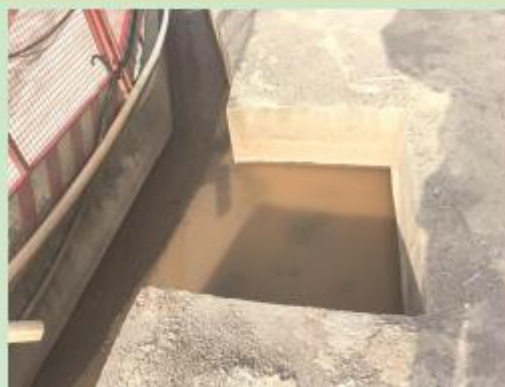
基坑周边临时沉砂池 2
