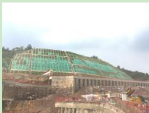
区内山体边坡区防护现状2
