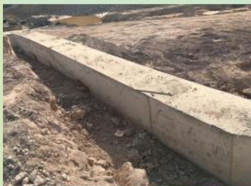
开挖区布设的混凝土支护梁
