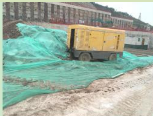
部分施工裸露面临时覆盖
