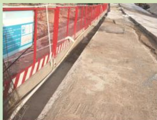
基坑周边临时排水沟 2
