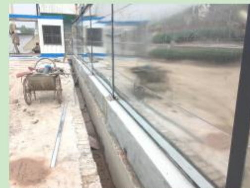
总包办公区部分围墙周边现状
