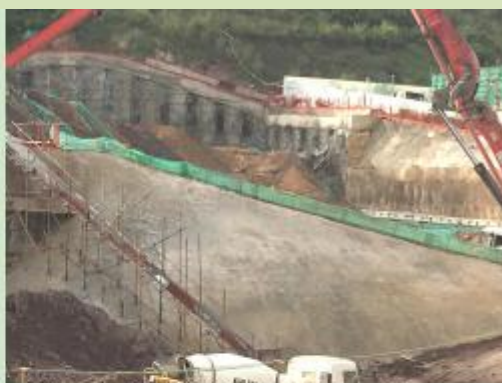
出土坡道侧面硬化现状
