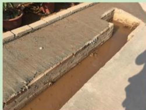
施工临建区周边排水沉沙设施
