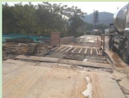
出入口洗车池周边现状
