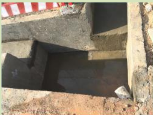
施工区内现有临时沉砂池1
