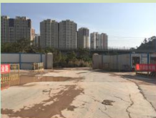
施工区出入口道路周边硬化
