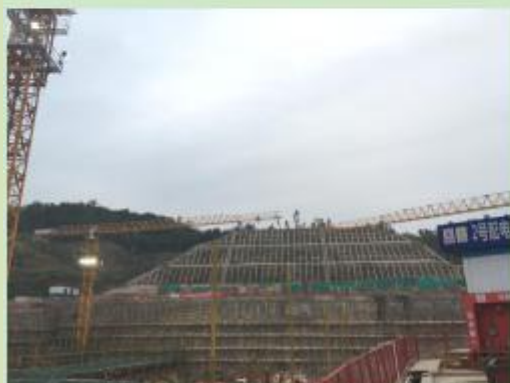
山体一侧基坑边坡防护现状 1
