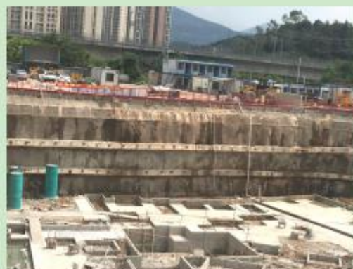
部分基坑边坡防护现状 2
