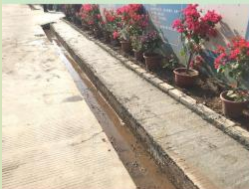
施工临建区周边排水及绿化
