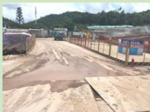
临时堆料区出入口周边现状
