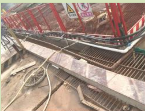
基坑周边临时沉砂池 3
