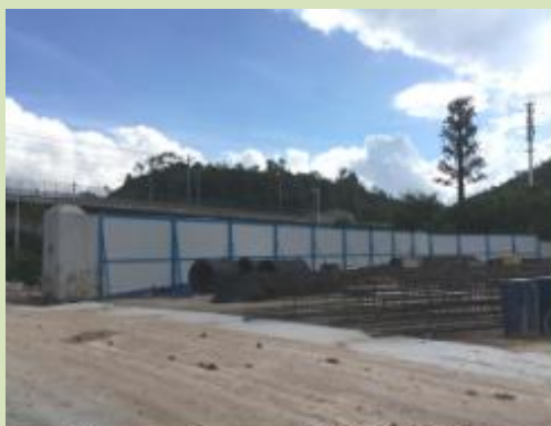
施工区入口一侧材料堆放区
