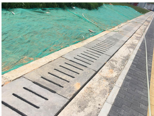
道路盖板排水边沟现状 2
