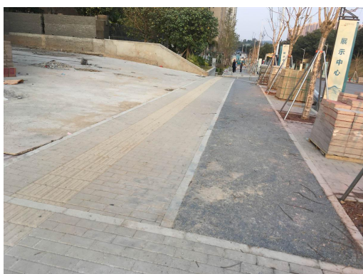
人行道硬化铺装现状 1
