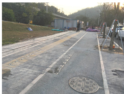
人行道硬化铺装现状 2
