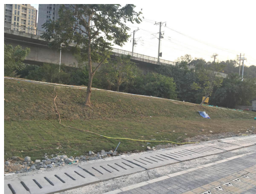
道路盖板排水边沟现状 1
